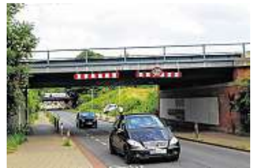
...ihre Sanierung ist in den Plänen für die kommenden Jahre noch nicht vorgesehen.
