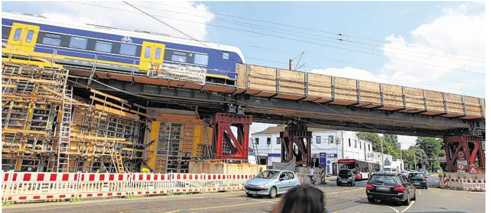
An der Hastedter Heerstraße können Bremer schon jetzt erleben, wie stark und wie lange der Straßenverkehr durch die Eisenbahnbrücken-Sanierung beeinträchtigt werden kann. FOTOS: FRANK KOCH
